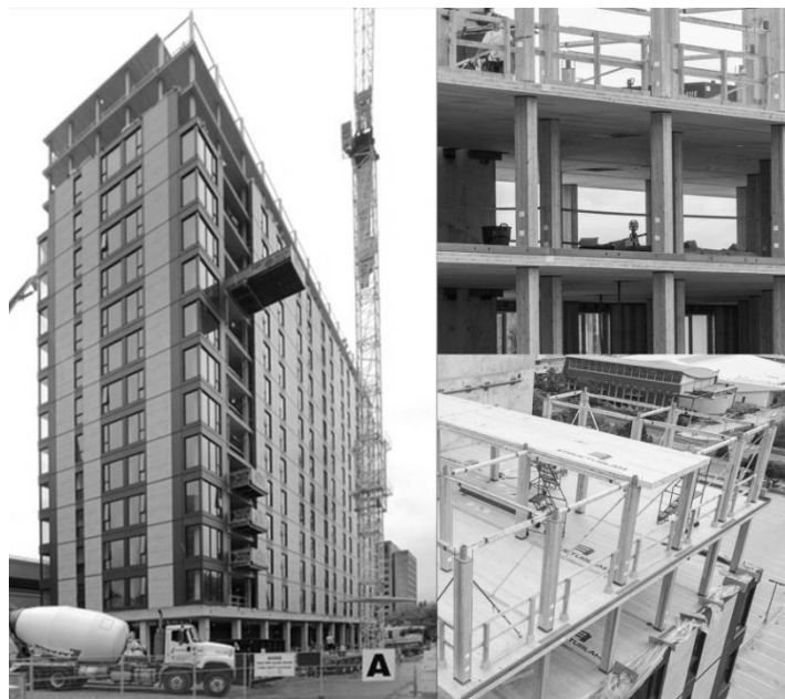
Рис. 4. Багатоповерховий будинок Brock Commons Phase (Британська Колумбія) [14]
