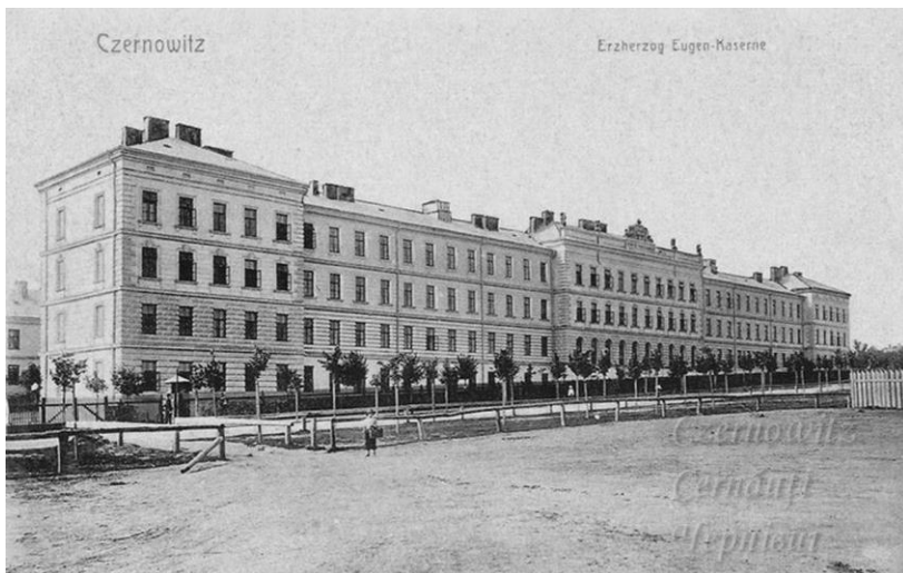
Рис. 4. Казарма ерцгерцога Євгена, м. Чернівці, вул. Садова, 1, нині – 19 корпус ЧНУ: План: фотофіксація головного фасаду (до 1914 р.)
