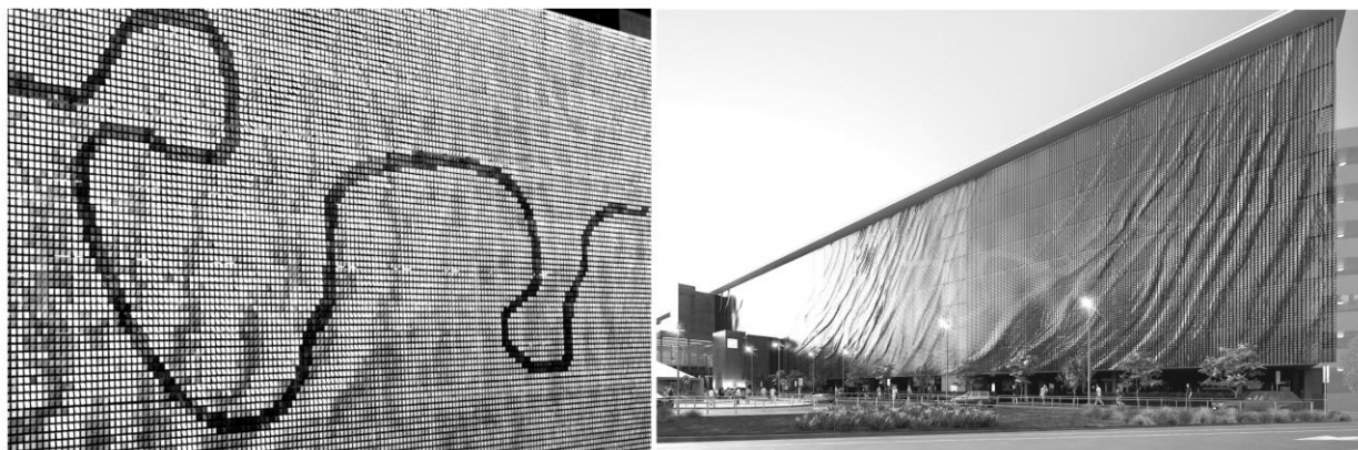
Рис. 6. Решение кинетического фасада перехватывающей МА аэропорта Брисбейн, арх. «Urban Art Projects», художник Нед Кан, Австралия, 2011
