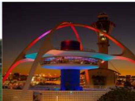
Рис. А.1.3. Тематична будівля в Лос-Анджелесі, 1961р.
