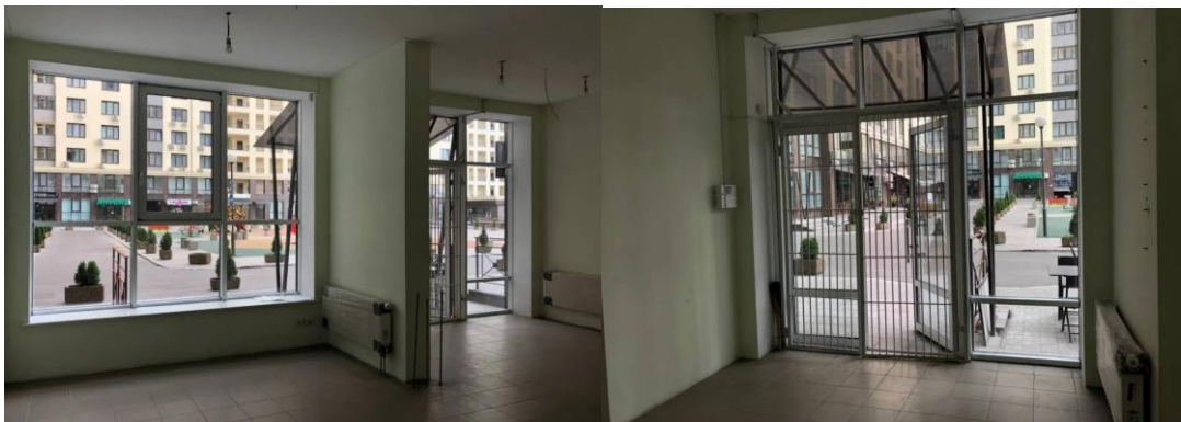
Рис. 2.2-2.3 Фото до реконструкції приміщення
