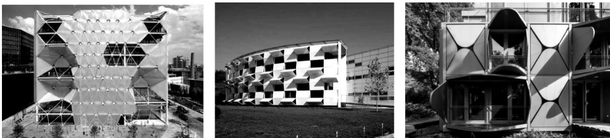
Рис. 3. (зліва направо) Будівля «Media-ICT» в Барселоні (Іспанія); офісна будівля Kiefer Technic Showroom в провінції Штірмарк (Австрія); житловий будинок «Механічний балет» в Цюріху (Швейцарія)
